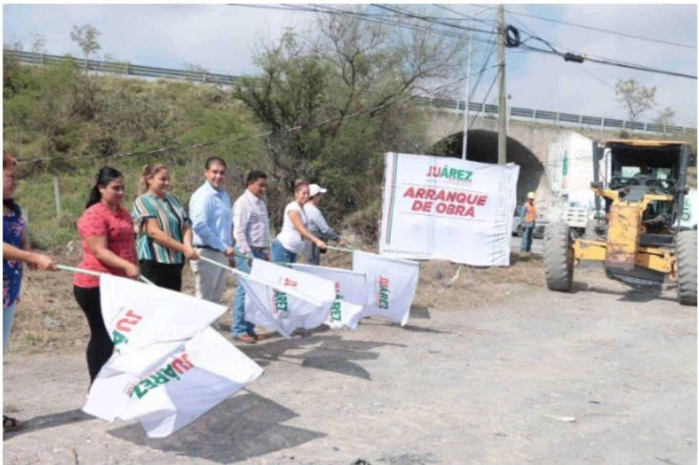
El alcalde Francisco Treviño Cantú encabezó el banderazo de arranque a las adecuaciones en el peligroso cruce de avenida Vistas de la Primavera y carretera Juárez-Apodaca, en la zona norte. FOTO: Municipio de Juárez
